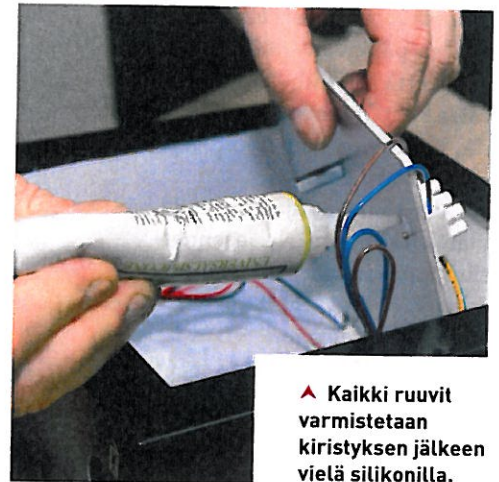
▼ Alakulmasta lähtee valaisimen keltavihreä maadoitusjohto.
